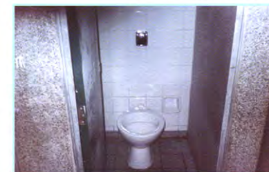
Bacia e válvula 6 L após as intervenções
