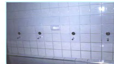
Torneiras com fechamento automático após as intervenções
