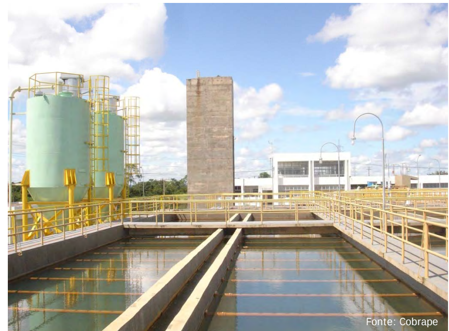
ETA Sobral – Visita técnica em Rio Branco/AC
