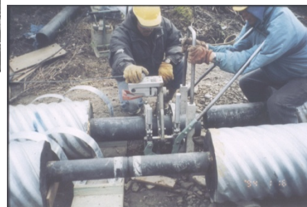
Sistema de distribuição
