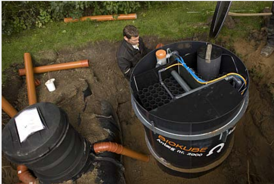
Unidade compacta para uma residência – BioKube Venus
