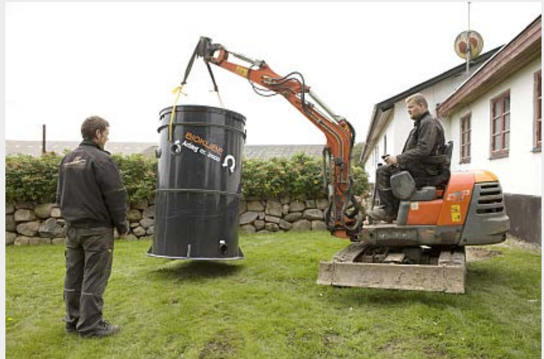
Unidade compacta para uma residência – BioKube Venus
