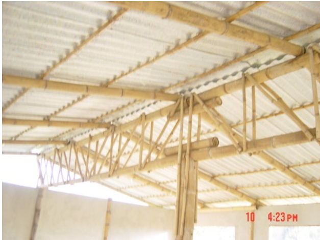
ESTRUTURA PARA COBERTURA
