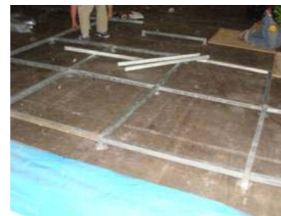
Piso com estrutura de ferro de reuso e revestimento de fibra natural
