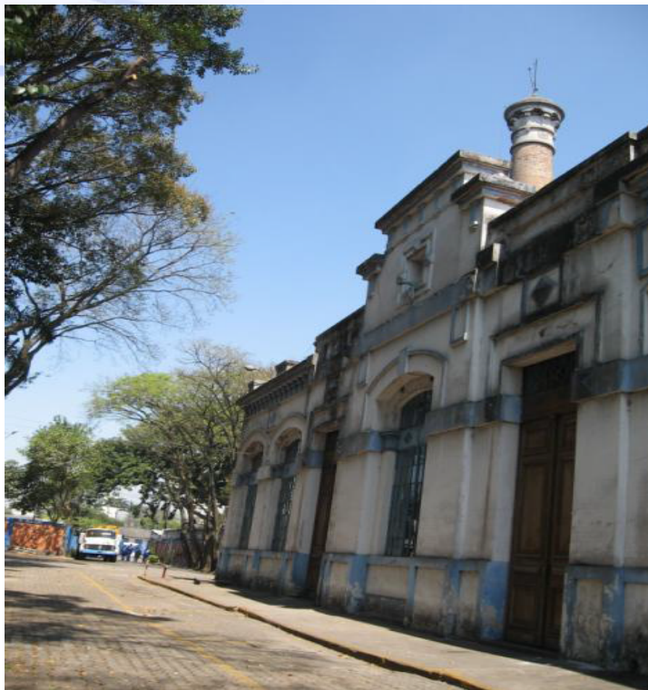
Estação Elevatória da Ponte Pequena (1876)
