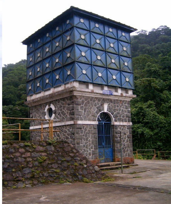
Estação de Tratamento de Água Pilões (Reserva Itutinga Pilões-Santos)
