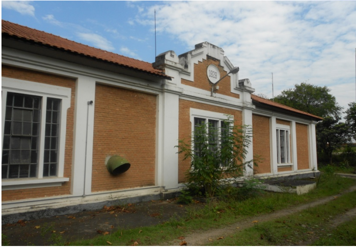
Estação Elevatória França Pinto (1929)
