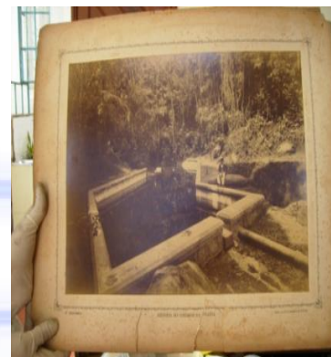
Represa do Córrego do Olaria (Serra da Cantareira)
