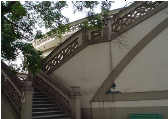
Reservatório da Vila Mariana (1914)
