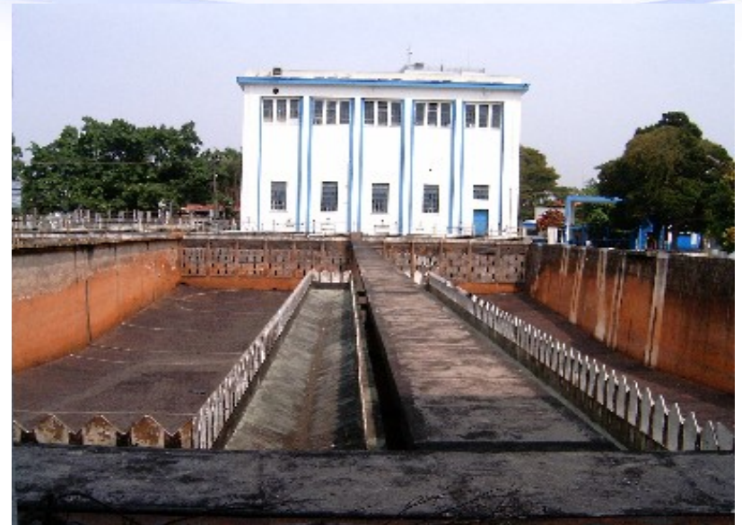
Antiga Estação de Tratamento Theodoro A. Ramos (1929)
