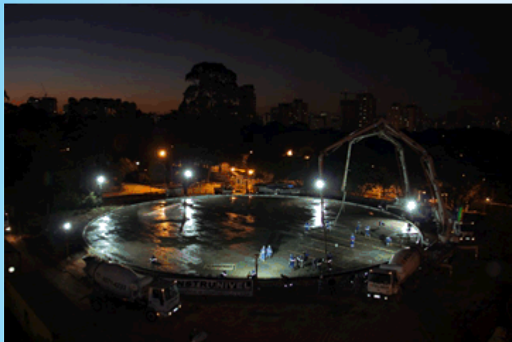
Reservatório ABV -20.000m 3
