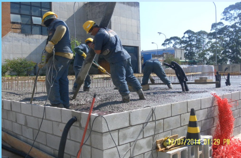
ETA Rio Grande – Membranas filtrantes
