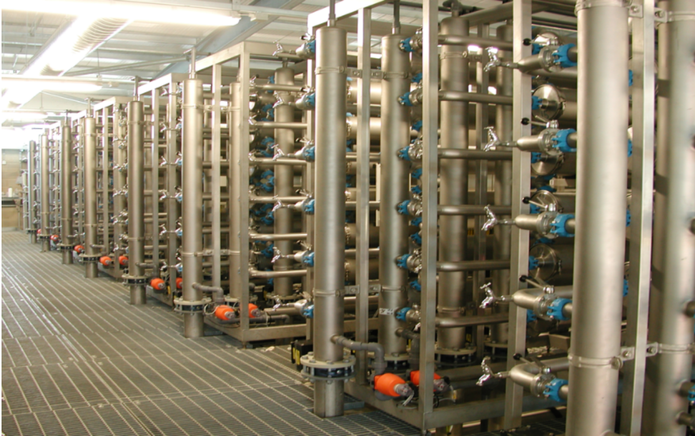
Clay lane, North London Area, UK 162.000 m 3 /d (água subterrânea)
