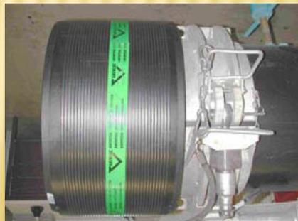
**7 - Verificar a folga entre a conexão e o tubo e substituir a conexão ou o tubo ou cortar a extremidade, caso necessário;**
