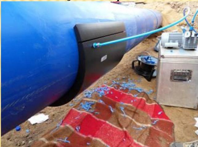
3. Aplicação de vácuo para contato entre reparo e a tubulação
