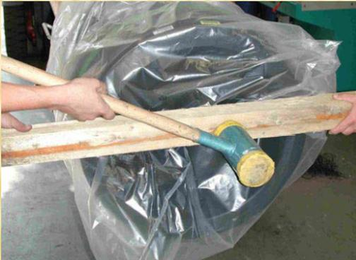
2. Inserir os tubos na conexão até o limitador com tubos perfeitamente alinhados.
