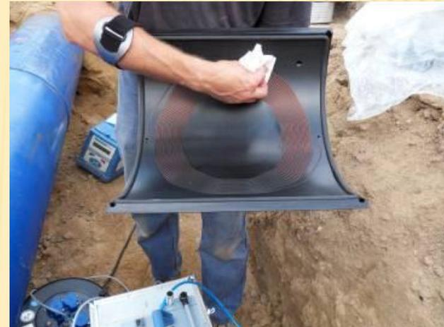
2. Limpeza dos componentes para instalação
