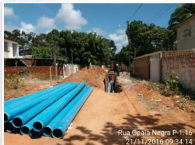
Implantação de 48km de redes Substituição de 60km
