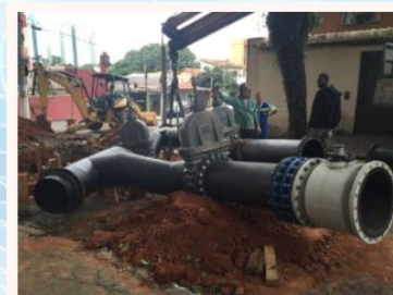
Implantação de 43 Macromedidores
