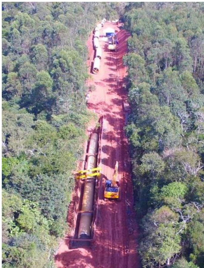
adutora de água bruta \phi 2.100 \text{ mm} , L = 49,3 \text{ km}
