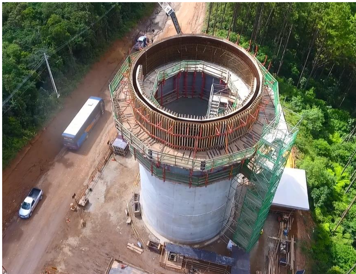
chaminé de equilíbrio \phi 12 \text{ m} e H = 21 \text{ m}
