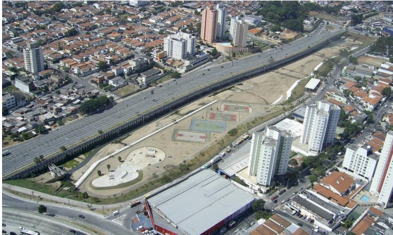
Reservatórios de Controle de Cheias Águas Espreadas
