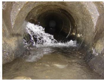
Antes – Vazamento com alta vazão
