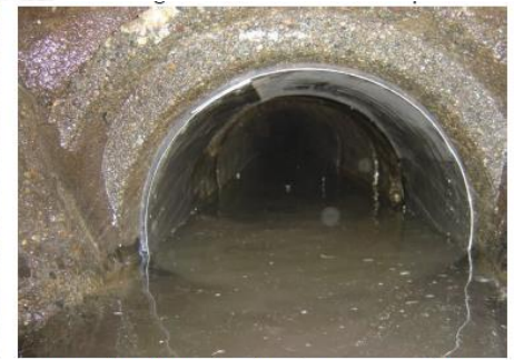
Depois – Reparo completo usando Sewer Sealer ™
