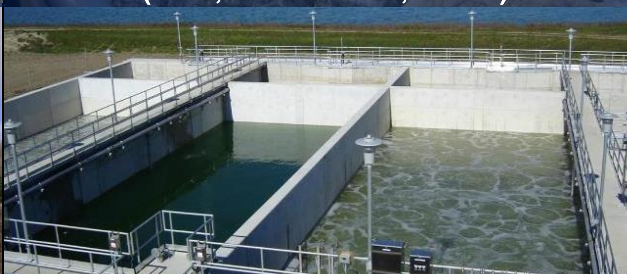
Ecoprocess SBR ( até 100,000 m 3 /d ou 700,000 PE)
