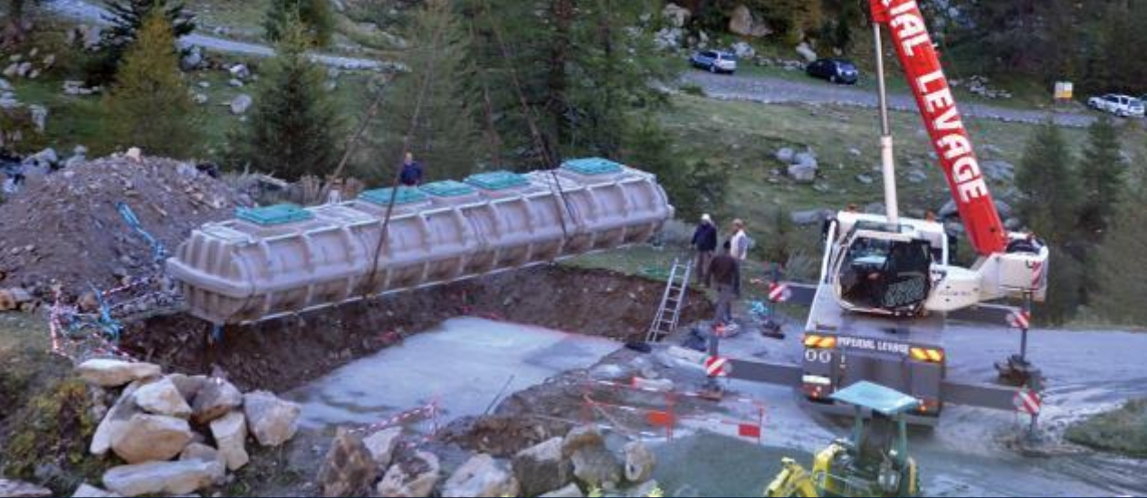
Ecoflo Coco Filter ( até 40 m 3 /d ou 270 PE)
