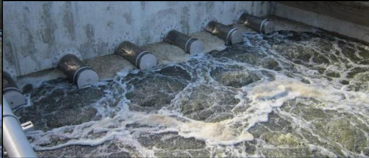
Ecoprocess MBBR ( até 1,000 m 3 /d ou 7,000 PE)
