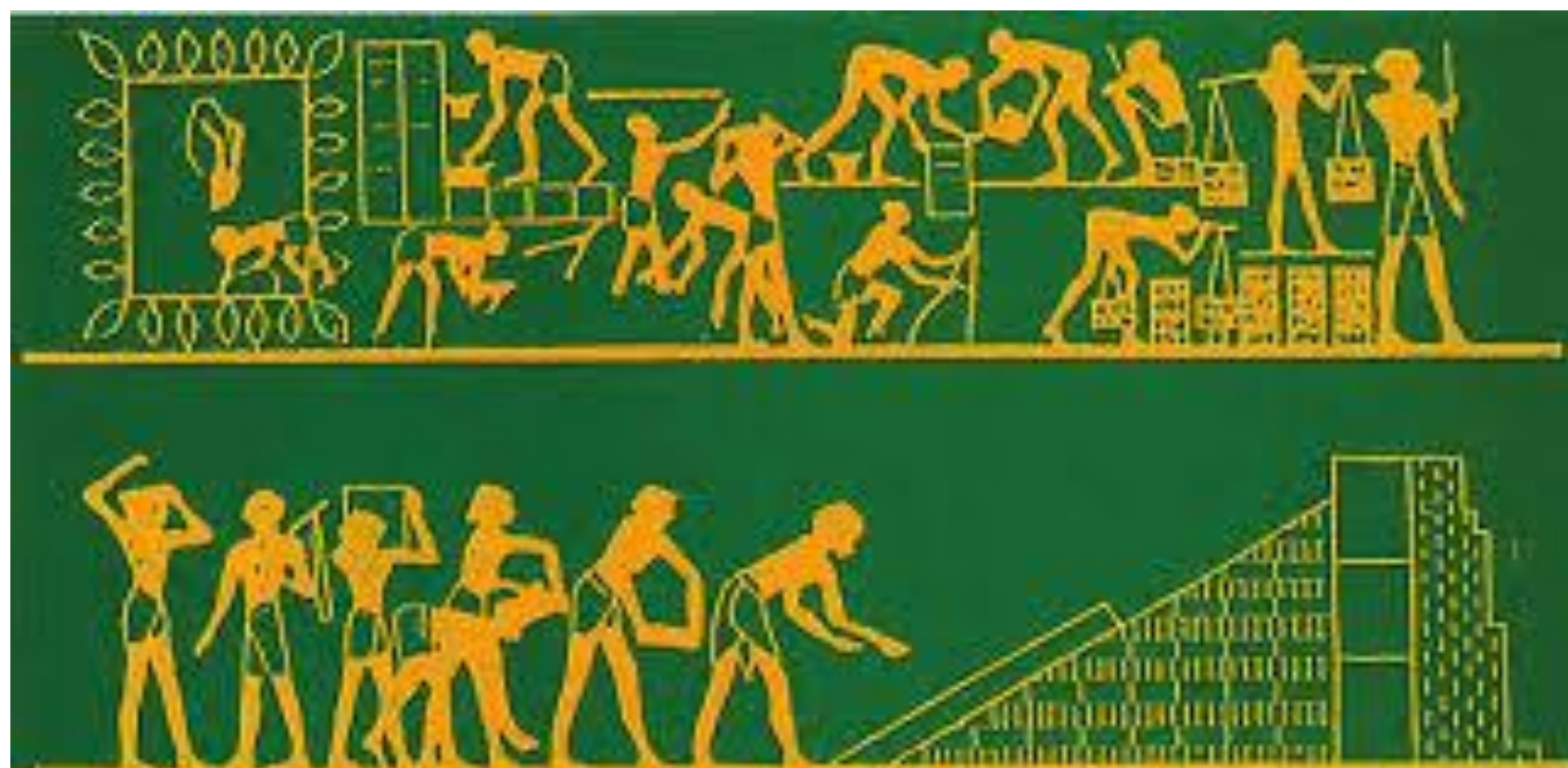
Figura 1: Mural egípcio retratando mistura manual de concreto (1950 a. C.) – S.M. Levy, P.R.L. Helene, 2002
