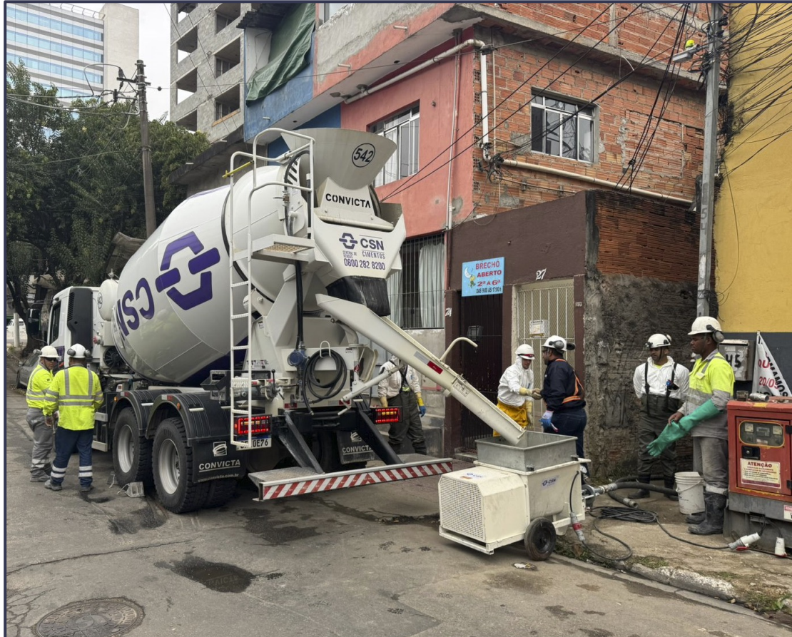
Solidarização da estrutura (injeção de graute)
