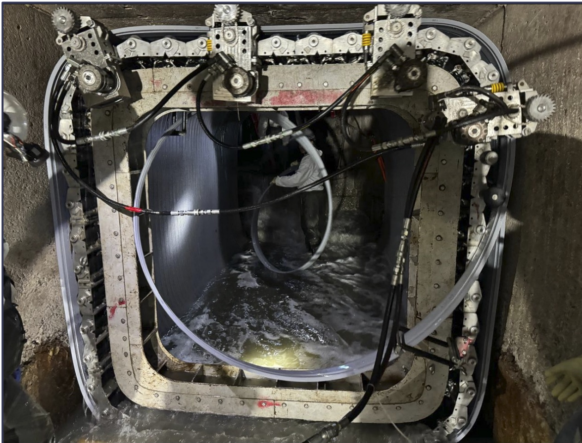
Conformação do Perfil (montagem do tubo)
