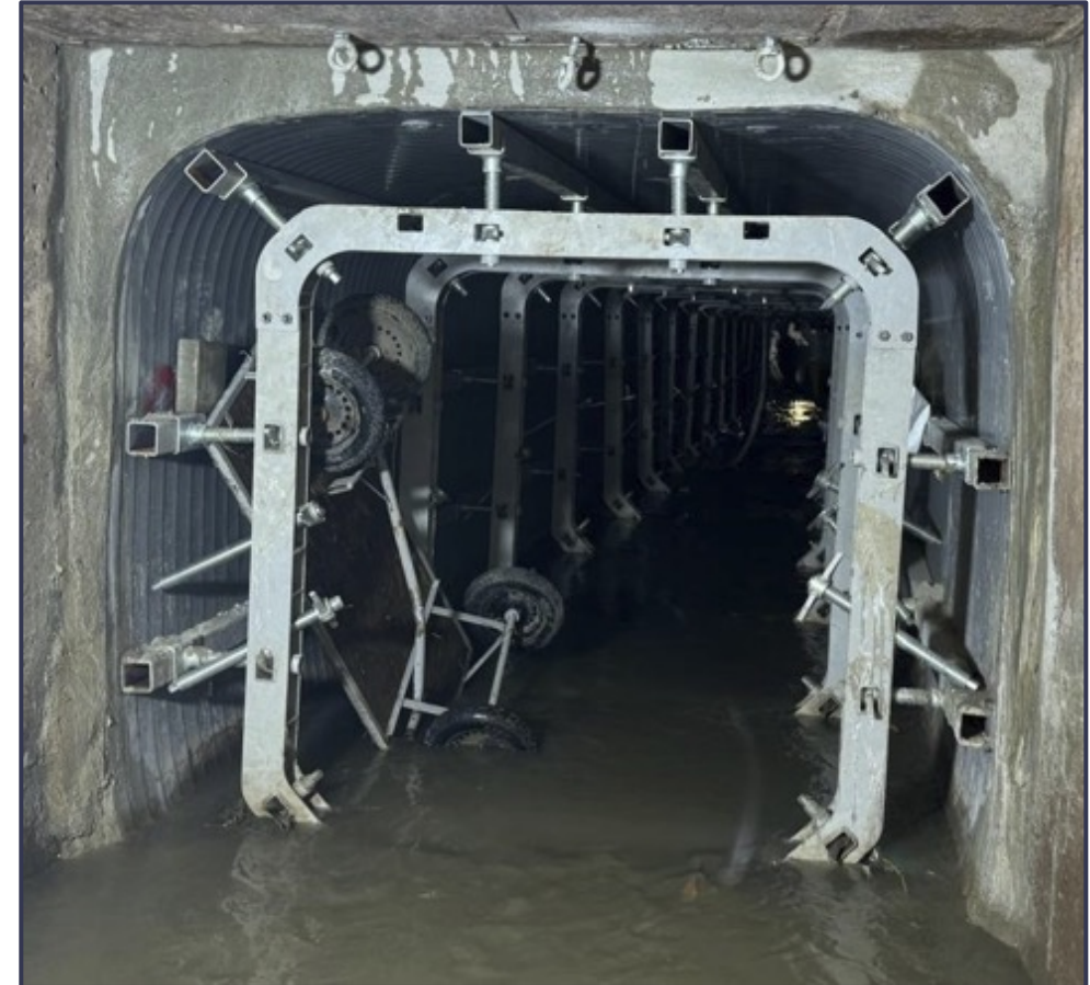
Solidarização da estrutura (injeção de graute)
