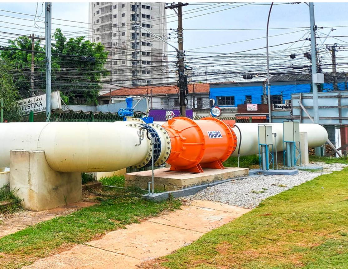
**Abastecimento de reservatórios:** controlando a vazão e aproveitando a pressão residual excedente;
