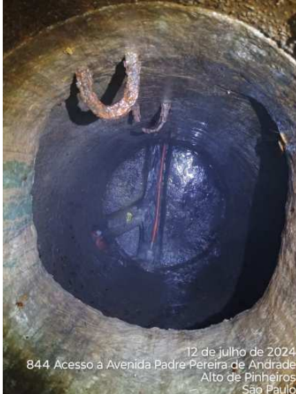
Figura 17 – Lavagem no Poço de Visita I
