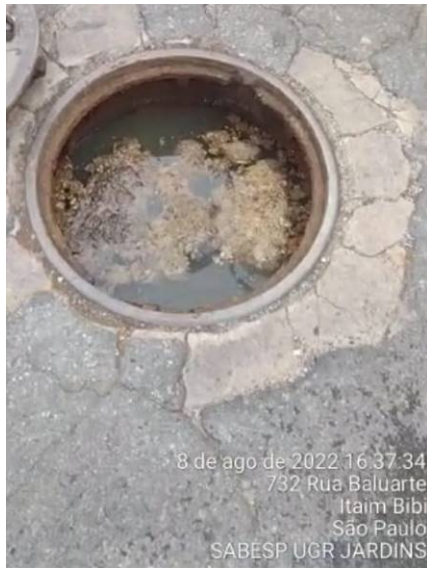
Figura 13 – Rede coletora obstruída na bacia do córrego Uberaba
