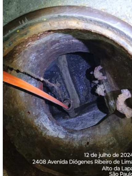
Figura 18 – Lavagem no Poço de Visita II
