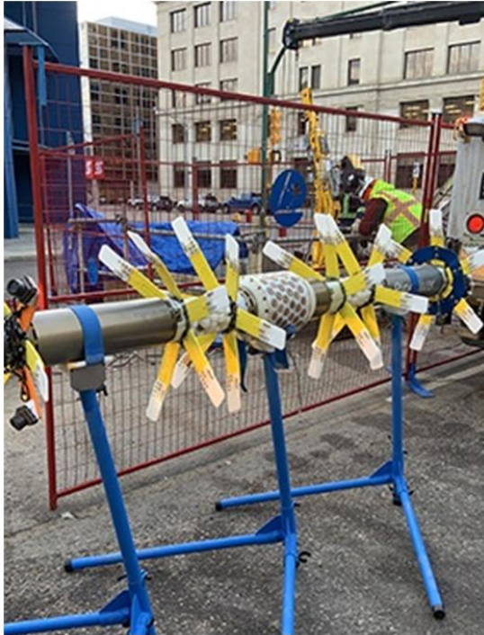
Figura 7. Preparação da inspeção da tubulação 1st Avenue: inserção no local
