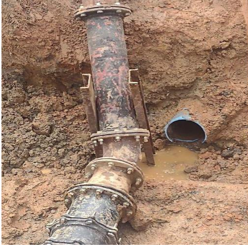
Figura 12 – Rede Defofo para ferro fundido
