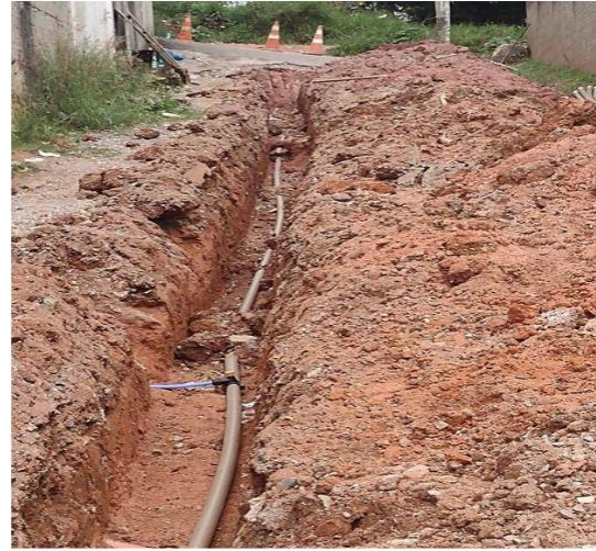
Figura 13 – Redes de ferro por PVC
