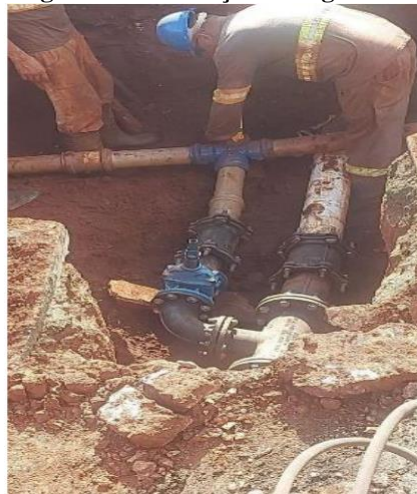
Figura 7 – Instalação de registro setorização
