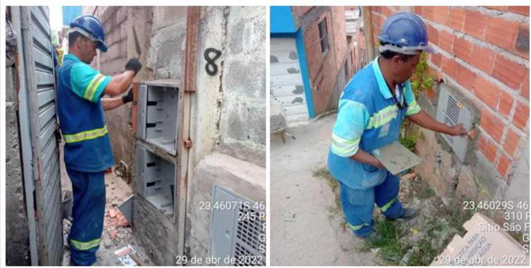
Figura 4 - Instalação de caixas UMA
