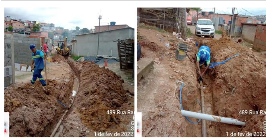
Figura 6 - Assentamento de novas redes de abastecimento de água
