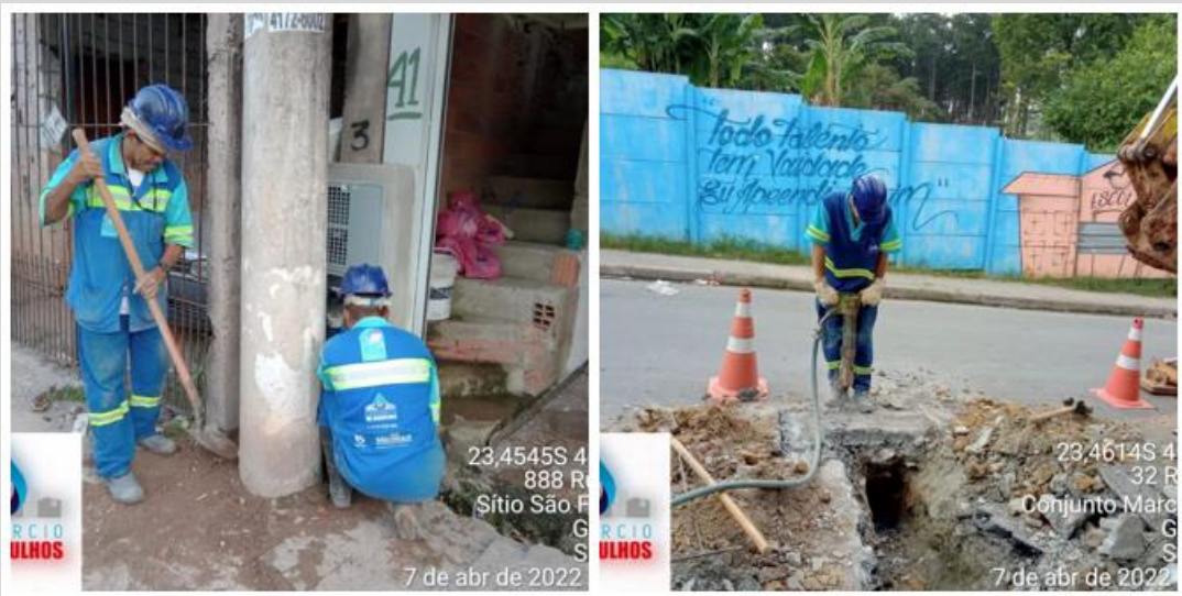
Figura 5 - Execução de novas ligações para abastecimento de água
