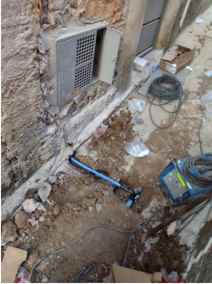
Figura 12: Exemplo de regularização, Ponte Alta
