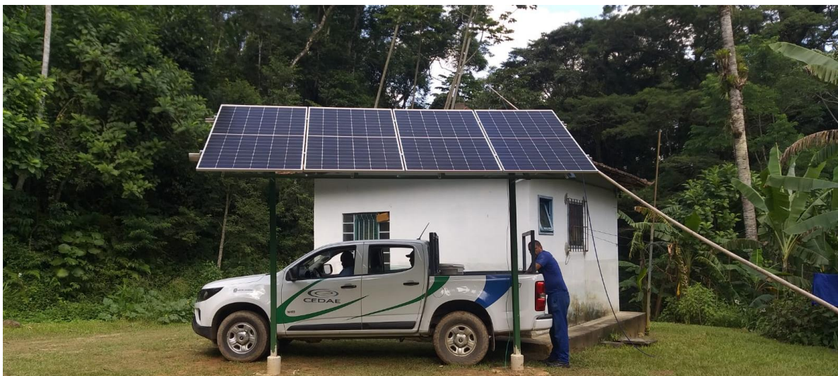
Figura 3. Placas solares instaladas em Xerém, no Sistema Acari/Linhas Pretas.
