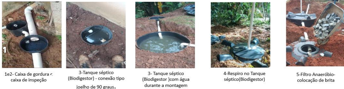
Figura 1: Instalação de Unidade Sanitária Individual – USI
