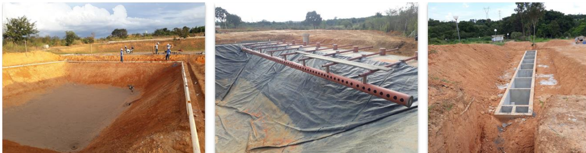
Figura 1: Imagens construção de lagoa/decantadores.
