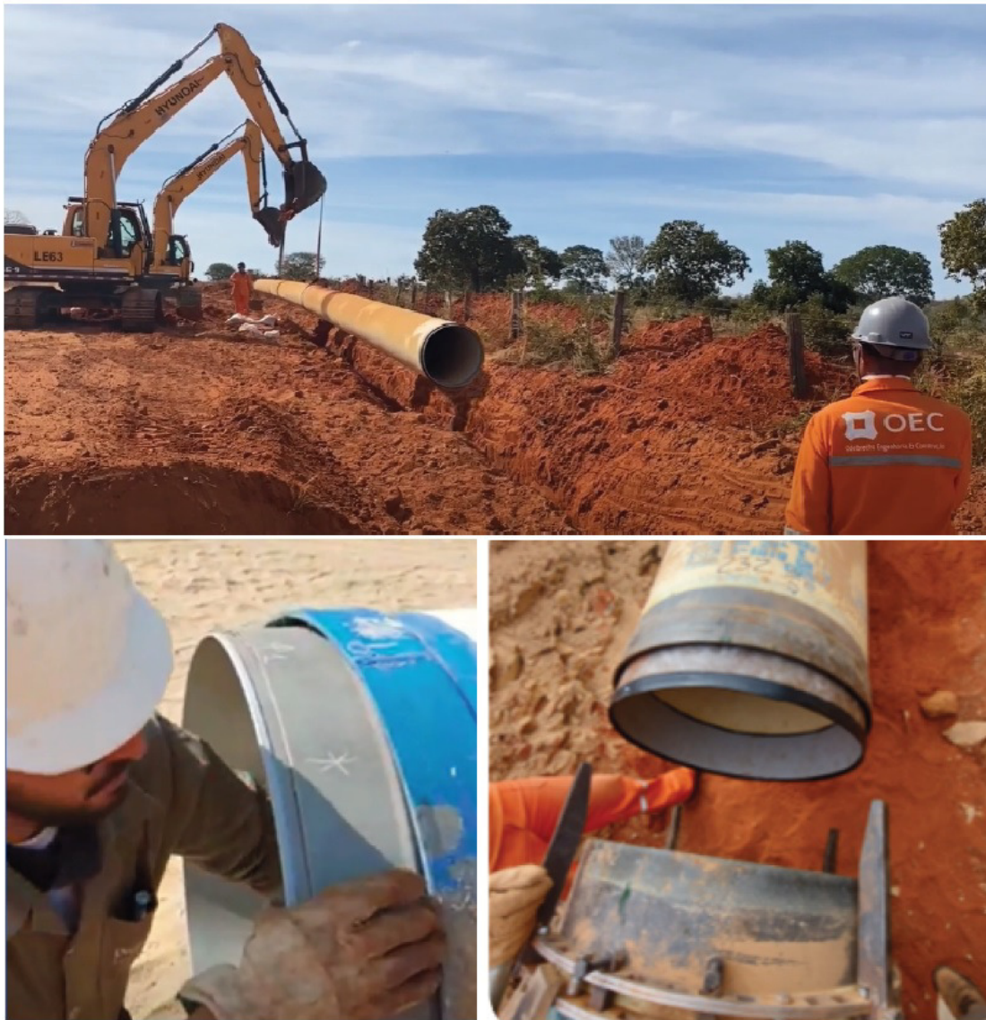
Figura 15 - Luvas internas de proteção e selagem de juntas soldadas usadas em juntas soldadas do tipo Butt Strap na construção da Adutora do Sistema São Francisco.
