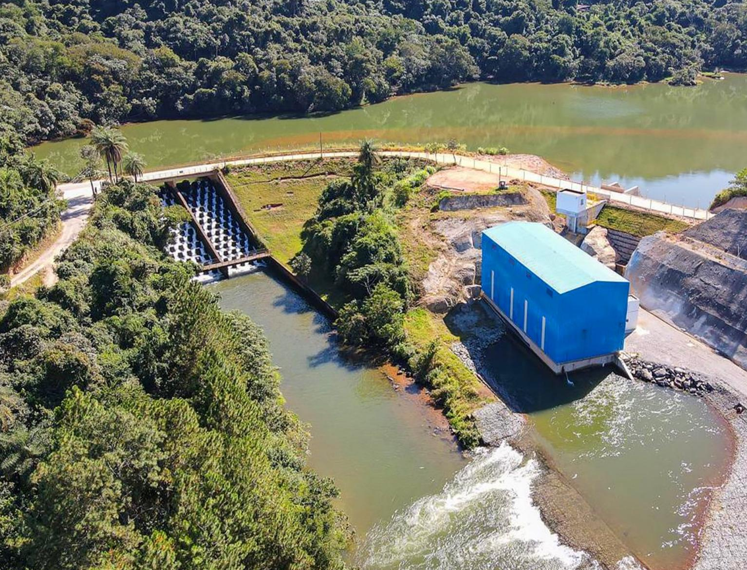
O arranjo da CGH Cascata contempla a implantação da estrutura da Casa de Força, da Tomada de Água, de um Canal de Adução e de um Conduto Forçado na ombreira do barramento.
