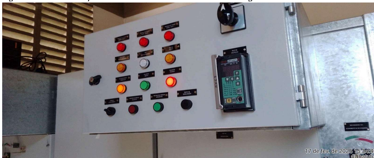
Figura 3 - Relé de Proteção - O Cérebro das Cabines Primárias Inteligentes
