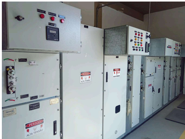
Figura 2 - Cabine Primária Blindada da ETE
