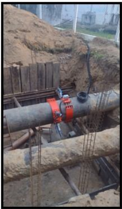
Figura 3 - Novo medidor Prados na saída do reservatório
