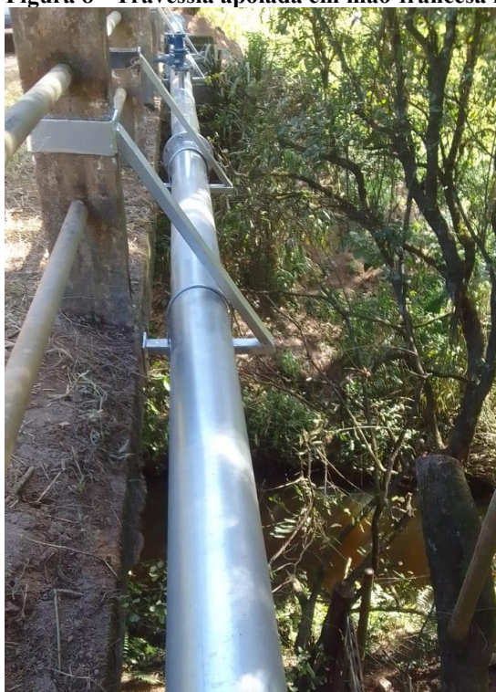
Figura 8 - Travessia apoiada em mão-francesa metálica
