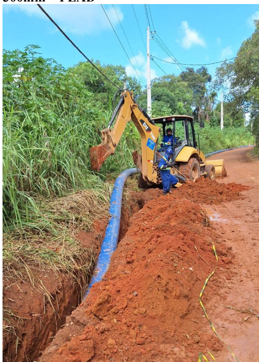
Figura 6 - Obra de assentamento de rede adutora através do método VCA (vala céu aberto) – DN 300mm – PEAD
