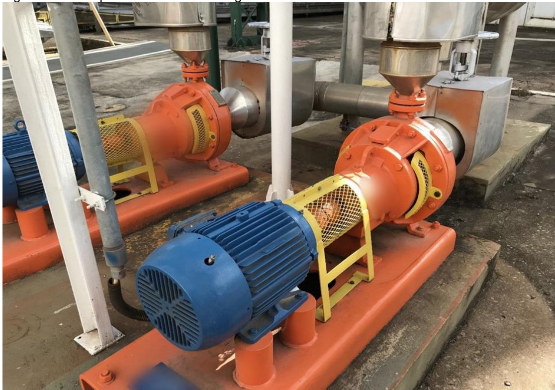
Figura 2 – Exemplo de bombas centrífugas instaladas em indústria
