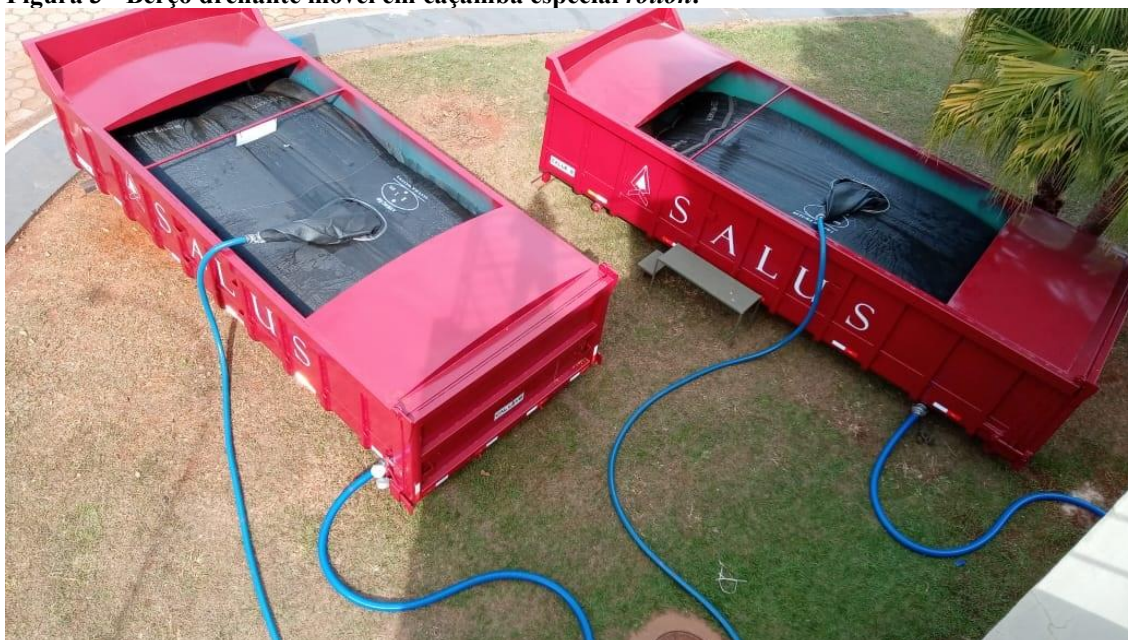
Figura 3 - Berço drenante móvel em caçamba especial rollon .
