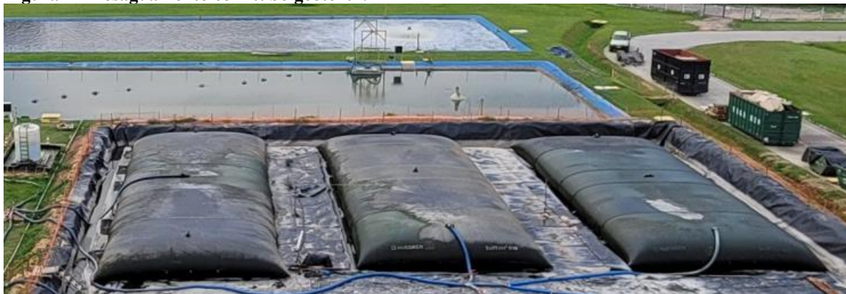
Figura 1 - Desaguamento com tubo geotêxtil.
