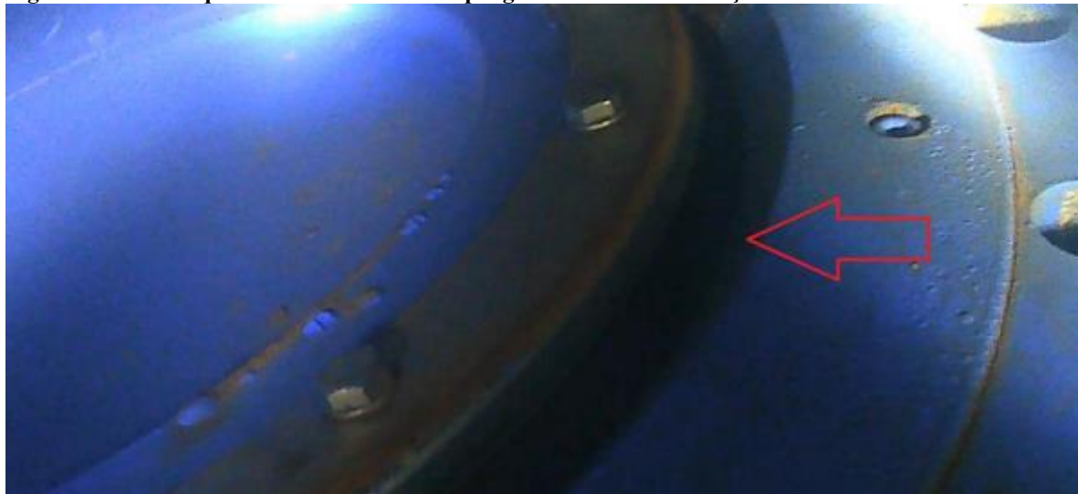
Figura 1 Não-estanqueidade de válvula de expurgo do sistema de filtração.
